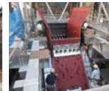
平成27年11月 焼却炉組立工事
