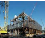
平成27年5月 地上鉄骨工事（メガトラス）
