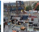
平成27年12月 プラットフォーム組み立て中の様子
