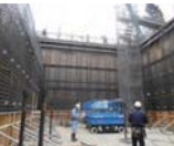
平成27年2月 地下工事（ごみピット施工の様子）
