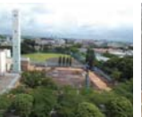
平成26年5月 工事着手
