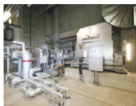
5 蒸气涡轮发电机
